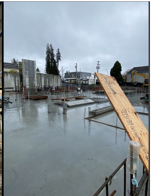
Final concrete slab pour
